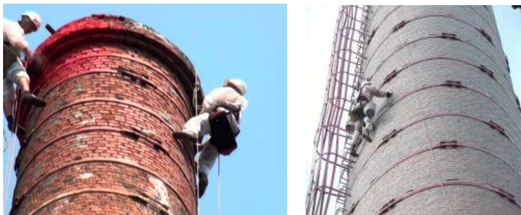
Рисунок 3 – Обстеження висотного будівельного об'єкту альпіністами
